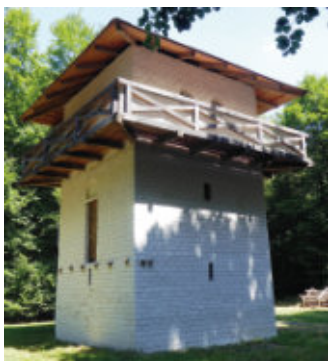
Limes-Wachturm in Limeshain: Der mit antiken Bautechniken und authentischen Baustoffen rekonstruierte römische Wachturm 3
